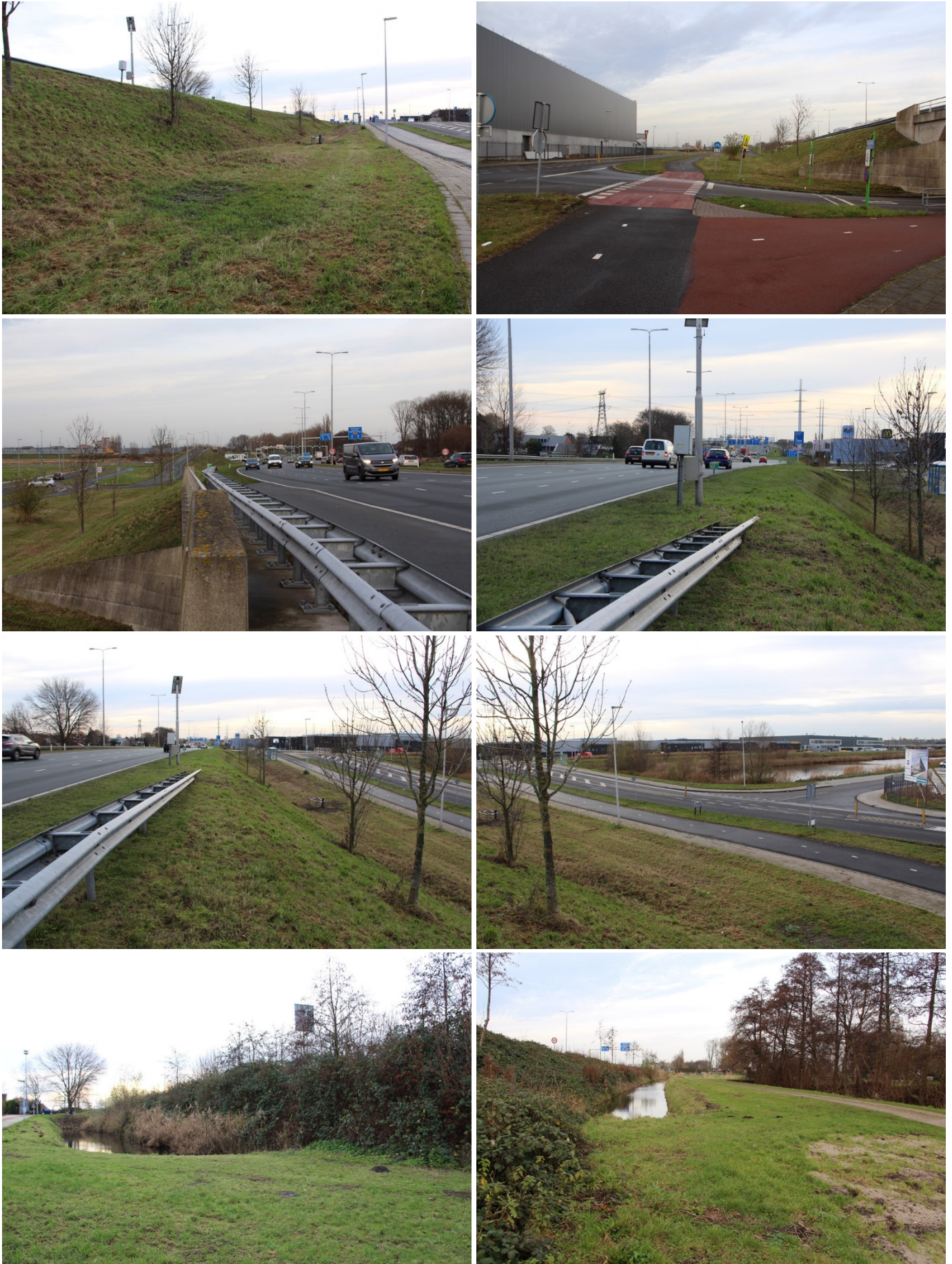
Figuur 13. Ten oosten van bedrijventerrein Prisma ligt de provinciale weg N209. De westzijde van het talud
