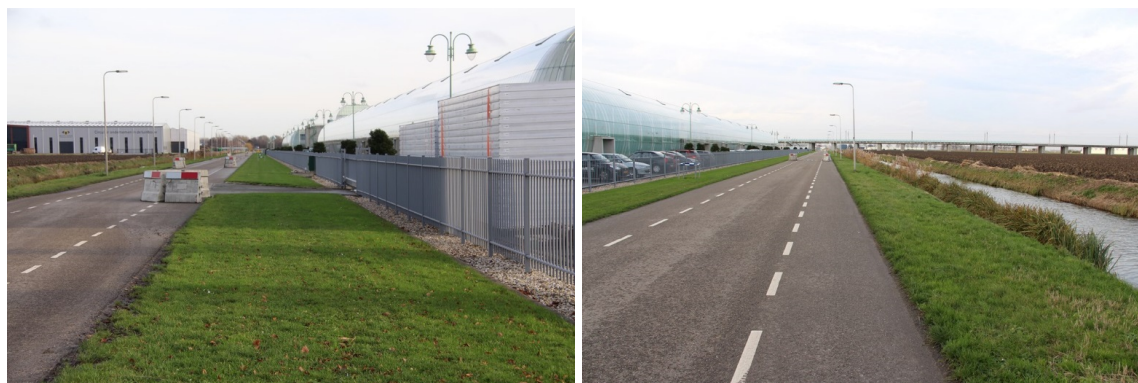
Figuur 8. De nieuwere glastuinbouwgebieden.
