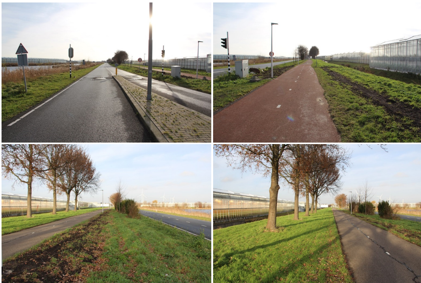
Figuur 5. In de huidige situatie zijn de bermen langs het fietspad en de busbaan niet zo heel breed en worden integraal gemaaid (zelfs tot aan de weg, terwijl er alleen maar een bus over rijdt). Dit verbeterd als aanzienlijk als de bermen worden omgevormd tot kruidenrijk grasland en gefaseerd beheer wordt toegepast. Zie kopje 'Kruidenrijk grasland'. Er is sprake van dat op termijn deze zone opnieuw wordt ingericht. In dat geval wordt aanbevolen om te kijken of het mogelijk is om de busbaan en het fietspad zoveel mogelijk tegen de kassen aan te leggen (op de onderste foto's zou dit dan helemaal rechts komen te liggen). Op die manier maakt men een bredere zone langs de rietkraag (zie het kopje 'Oude takken en stengels', waarom riet waardevol is), die een geleidelijker overgang kent en in zijn geheel kan worden ingericht met deels nat kruidenrijk grasland. De bredere zone is op die manier veel robuuster en duurzamer voor de wilde bijenfauna dan in de huidige situatie. Ook moet in de huidige situatie het beheer continu optimaal zijn om goed te kunnen functioneren als verbodingshabitat voor de bijenfauna.
